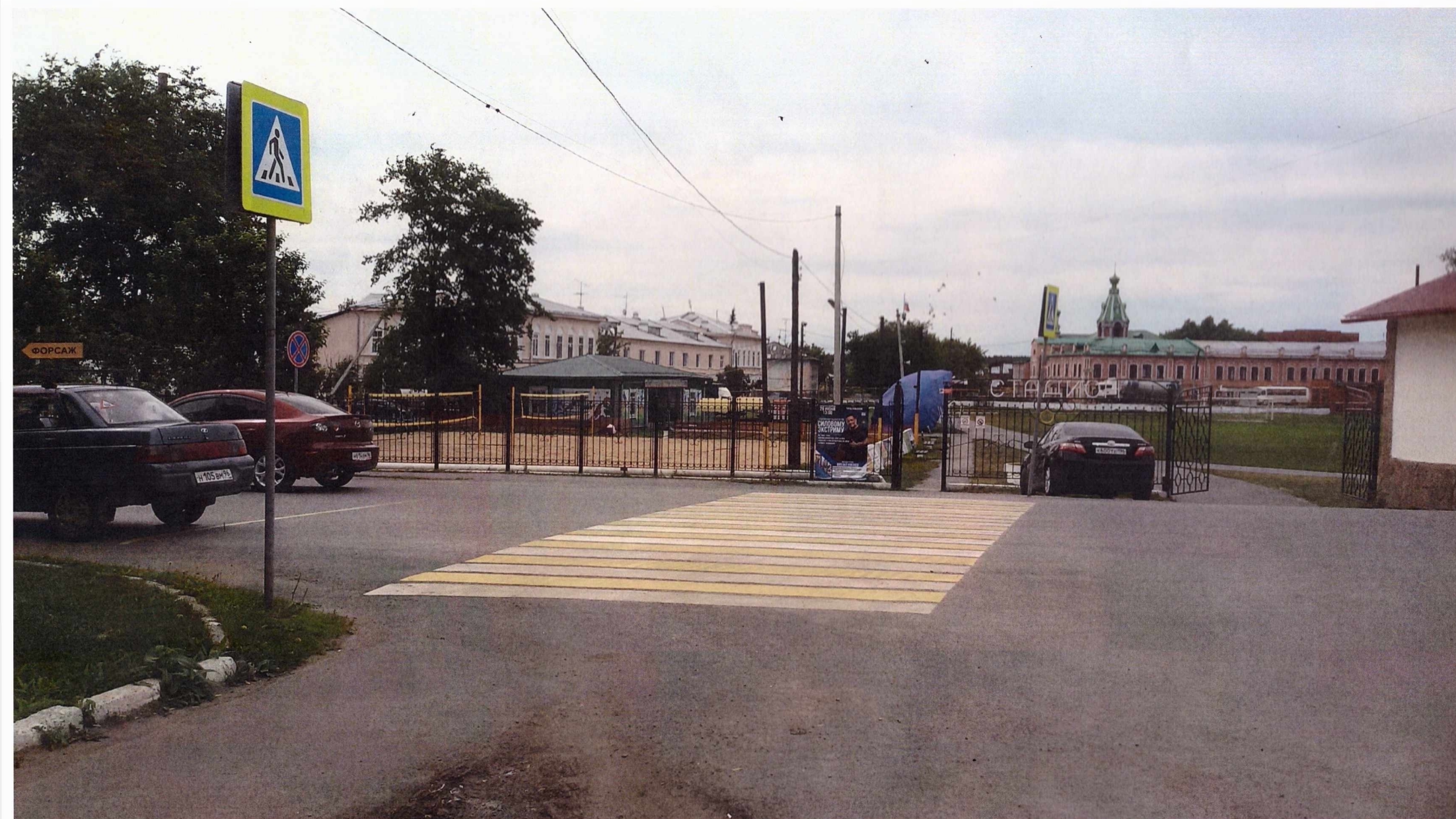
Перекресток ул.Маяковского – ул.К.Маркса (вид со стороны ул.Маяковского). Пешеходный переход до стадиона через ул.К.Маркса).
