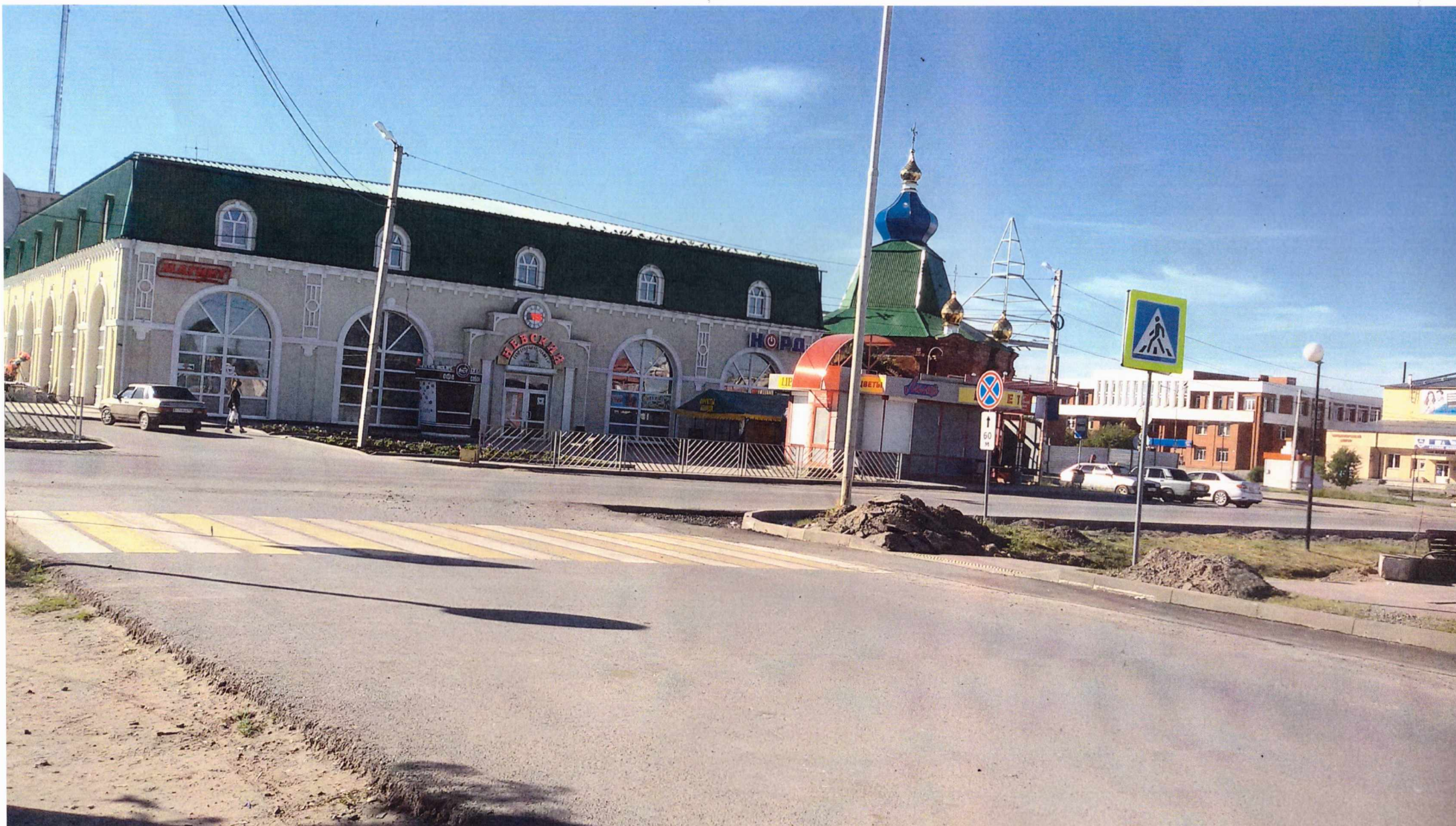
Перекресток ул.Ленина- ул.К.Маркса (вид со стороны ул.К.Маркса). Пешеходный переход через ул.К.Маркса.
